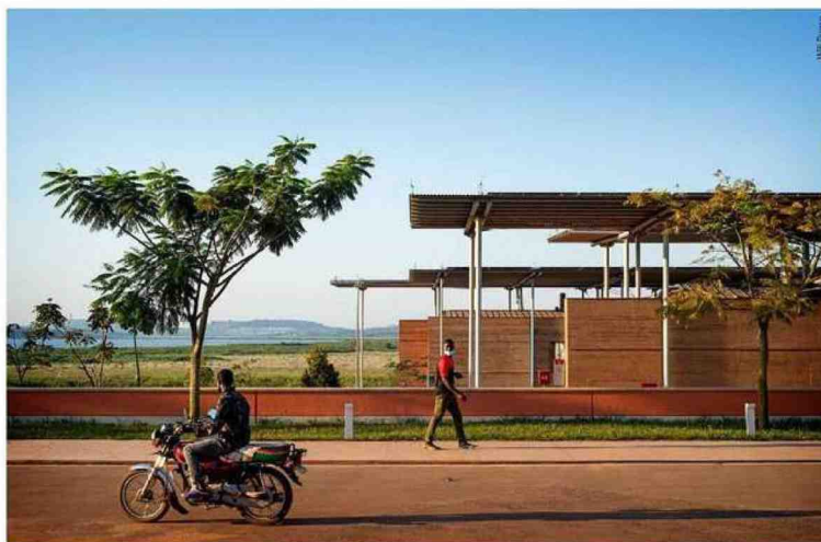
Le coperture parasole in relazione con il paesaggio e la linea orizzontale del Lago Vittoria The sun shielding roofs in relation with the landscape and the horizontal line of Lake Victoria
