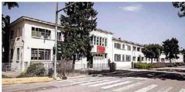
Il quartier generale di Fiamm a Montecchio Maggiore
