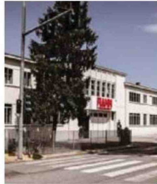
Sede Fiamm Energy Technology
